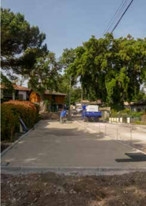
Travaux rue des chênes-lièges
