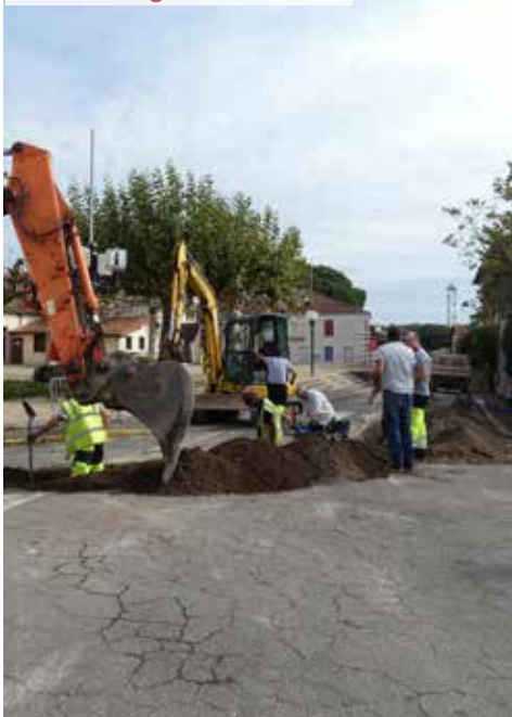
Début des grands travaux
